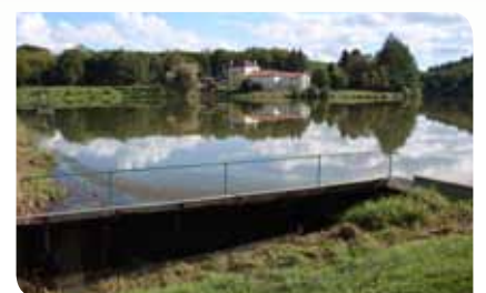
Étang de Rochechouart réaménagé
