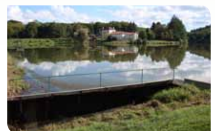
Étang de Rochechouart réaménagé
